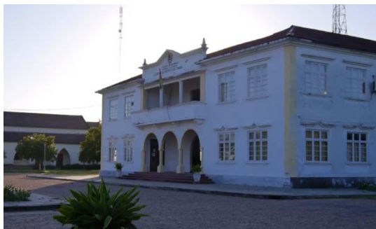
Figura 21 – Edifício do Governo Distrital
